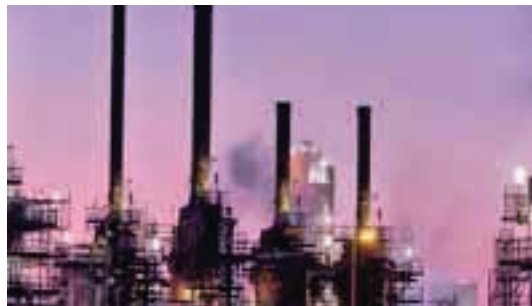
Maintenance générale ateliers de mécanique entretien
